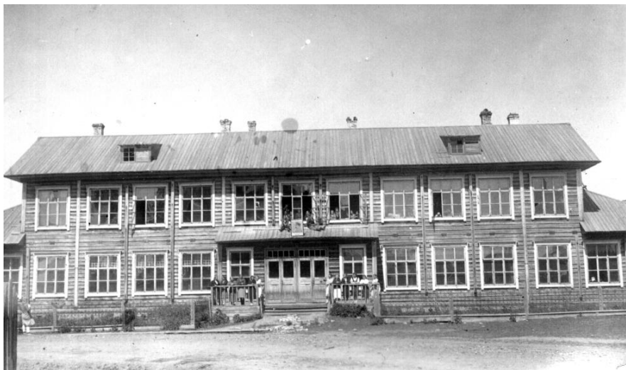
К открытию средней полной школы в 1938 г., было построено новое здание школы
