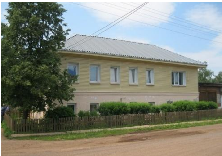
с.Юсьва, ул. Красноармейская 5, дом Ныробцева К.А.
